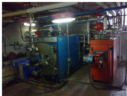
Figura 6 Centrale termica Galilei, particolare delle due caldaie
