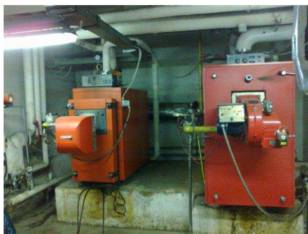
Figura 8 Centrale termica "Sanzio", particolare delle due caldaie
