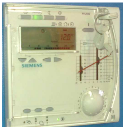
Figura 10 Sistema di regolazione centrale termica "Sanzio"
