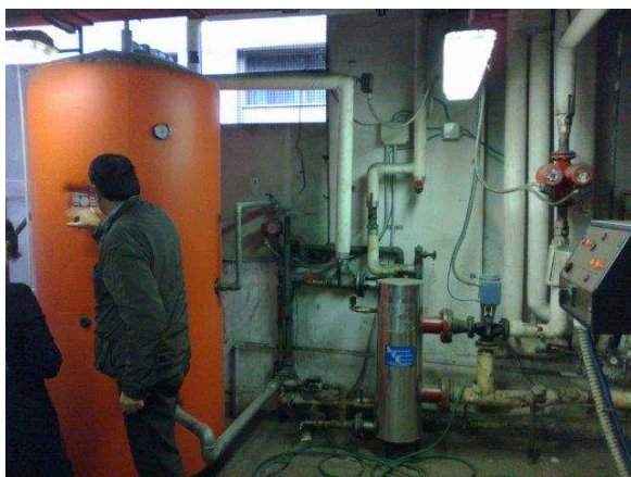
Figura 9 Serbatoio ACS centrale termica "Sanzio"
